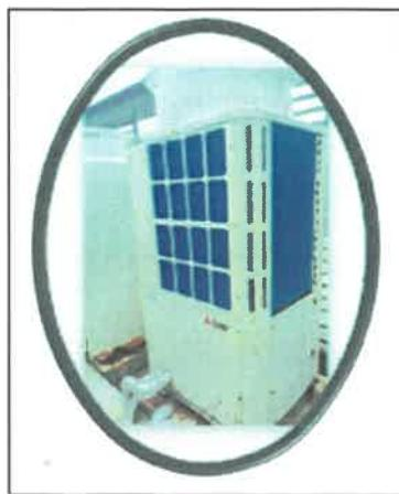
Imagen 7 - Unidade exterior de ar condicionado
